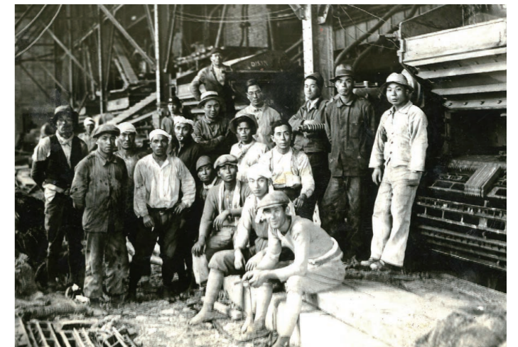
樺太でのボイラー据付時代
