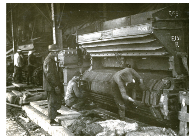
樺太でのボイラー据付
