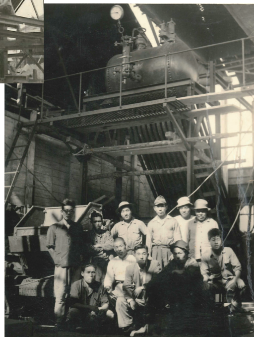
ボイラーの据付時代 (昭和25年)
