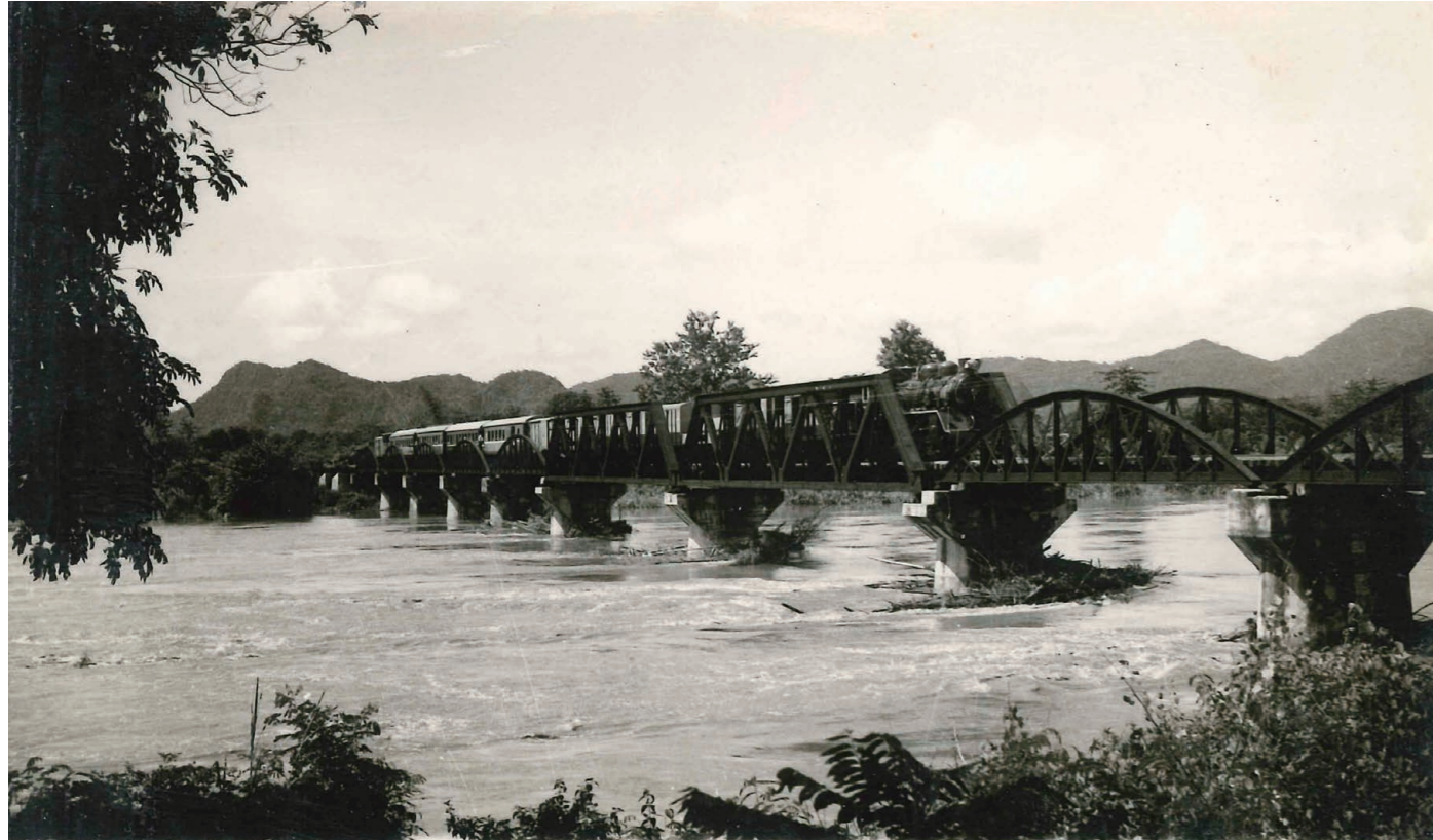
タイ・カンチャナブリ鉄橋 日本軍がビルマに抜ける鉄道を作ったもの
