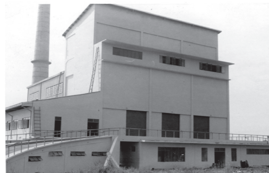
W-700型を建設したゴミ焼却場 フィリピン ケソン市
