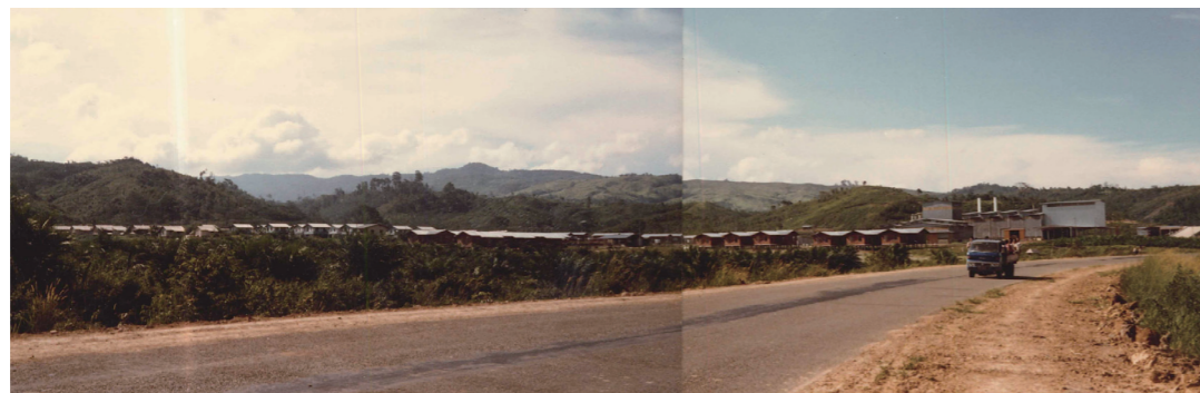
LANGKON OIL PALM工場と住宅 マレーシア(昭和54年)
