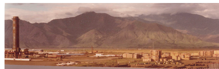
パプアニューギニア RAM SUGAR 現場事務所からのH-1300型×2基用の煙突(昭和56年)
