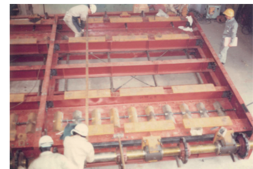
京都工場にてストーカー仮組み中
