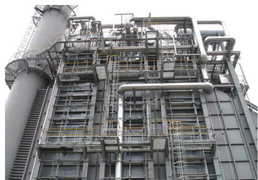
建設中のHRSG-26000型
