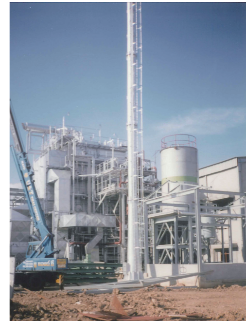
H-900型コーン粕焚きボイラー建設中
