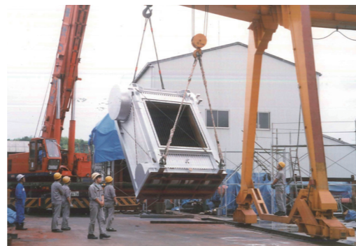
搬送のため横倒しされるWBF320型ボイラ
