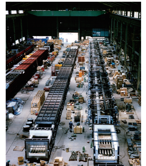
組立中の連続焼鈍炉(拡張期)
