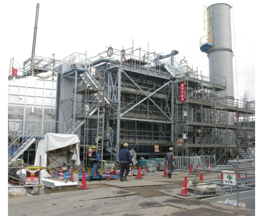
建設中のWBF-1100型
