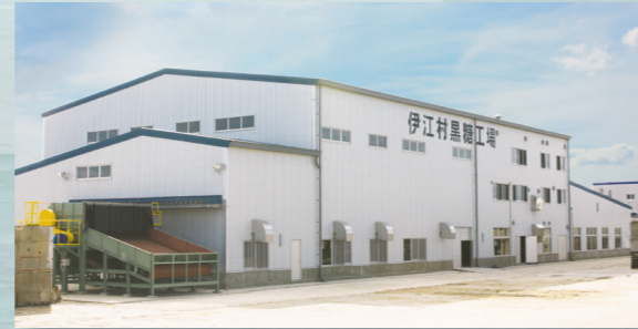
HAS-4000型 伊江村黒糖工場全景
