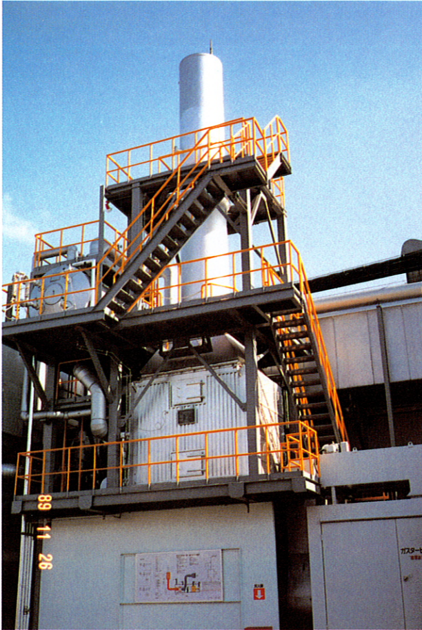
写真 3 : 某自動車会社向 WEF-1100 型 9.5\text{T}/\text{H} \times 10\text{kg}/\text{cm}^2 \times 4000\text{kW} \times 1 基
