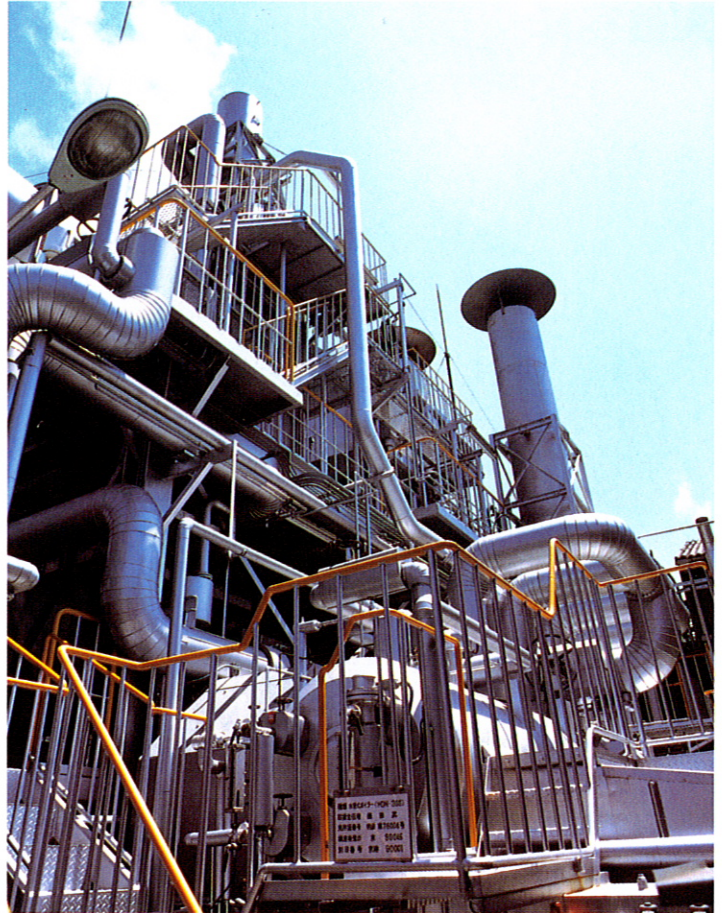
写真 4 : 某製紙会社向 WBF-310 型 13\text{T}/\text{H} \times 13\text{kg}/\text{cm}^2 \times 6000\text{kW} \times 1 基
